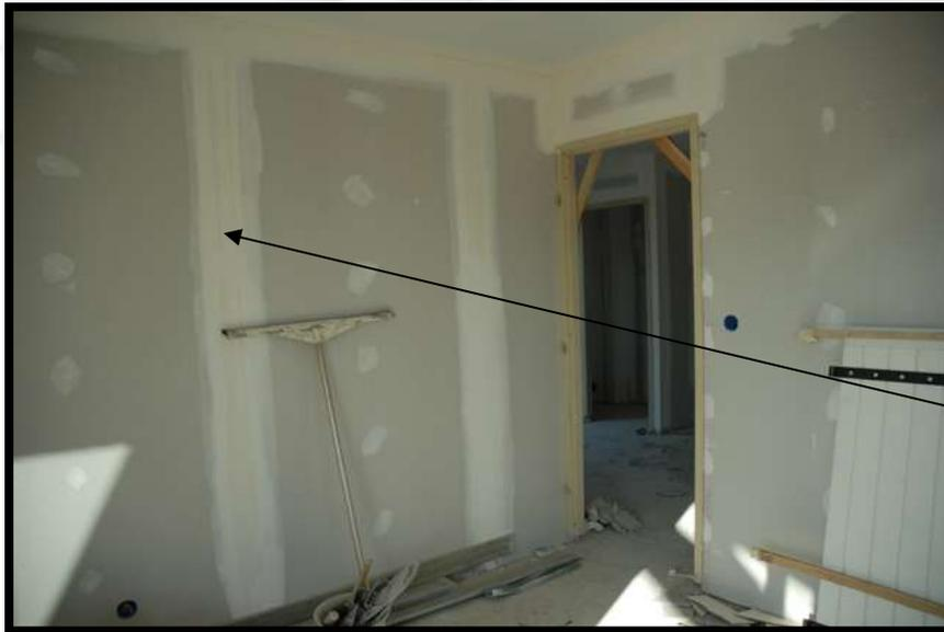
**Une fois toutes les plaques de plâtre vissées sur les ossatures métalliques, on passe à la finition des joints.**
