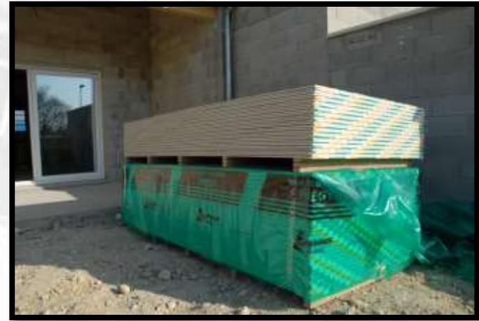
**Des plaques de plâtre ayant une épaisseur de 13 mm sont stockées et vont servir à la réalisation des cloisons.**
