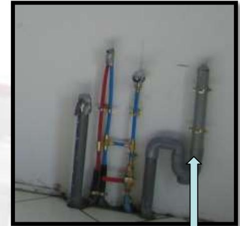
Il met en place les arrivées d'eau et aussi les canalisations qui permettront l'évacuation des eaux usées de la cuisine ou de la salle de bain.
