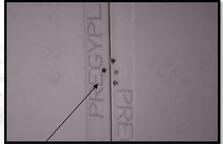
**Vis à la jonction de deux plaques de plâtre.**
