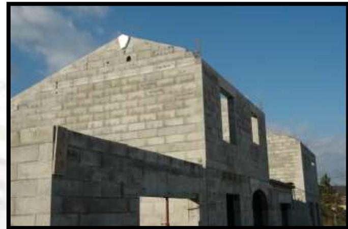
**Les murs sont montés, les ouvertures apparaissent aux emplacements indiqués sur les plans.**
