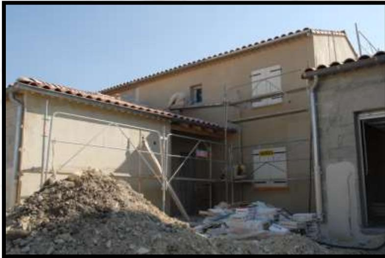
On met en place des échafaudages afin de réaliser les enduits et les peintures extérieures.
