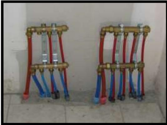
Raccordements eau chaude (tubes rouges) et eau froide (tubes bleus).
