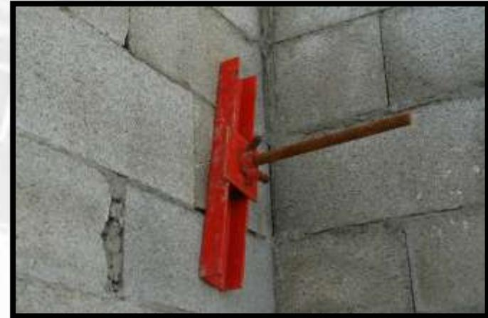
**Côté intérieur, le système de fixation de la passerelle de travail (des tiges traversent le mur).**
