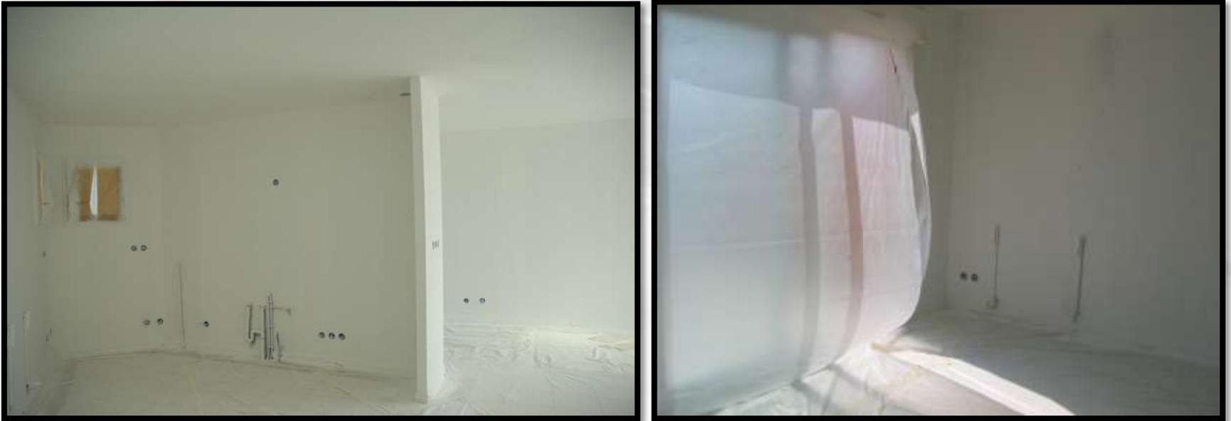
**On protège les sols et les fenêtres pour réaliser la peinture des cloisons.**
