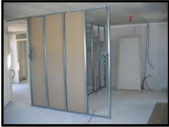
**Les plaques de plâtre sont vissées sur l'ossature métallique de la cloison d'un côté... et de l'autre.**
