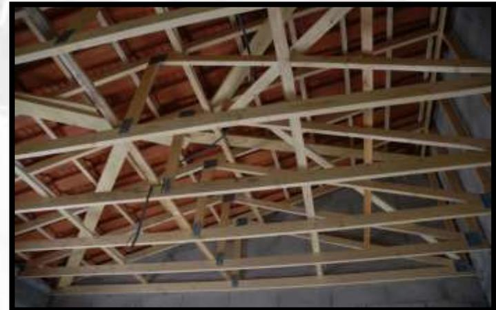
**Charpente industrielle. Les fermettes (assemblage d'éléments de bois assez fins) sont préfabriquées en usine puis posées sur le chantier.**
