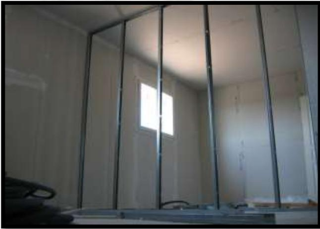
**Une ossature métallique allant du sol au plafond est mise en place.**
