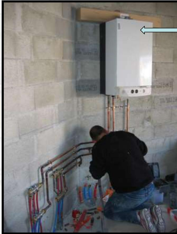
Le plombier installe le système de chauffe de l'eau (chaudière, ballon d'eau chaude, ...).
