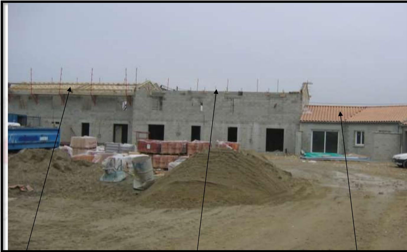
**Mise en place de la charpente industrielle (fermettes).**
