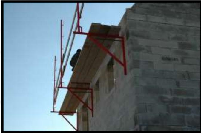
**Passerelle de travail installée côté extérieur du mur de façade.**
