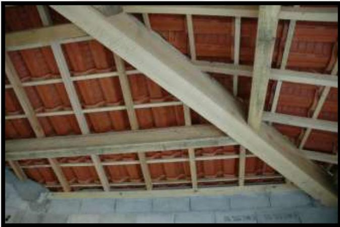
**Charpente traditionnelle réalisée sur le chantier avec de grosses poutres en bois appelées des pannes.**
